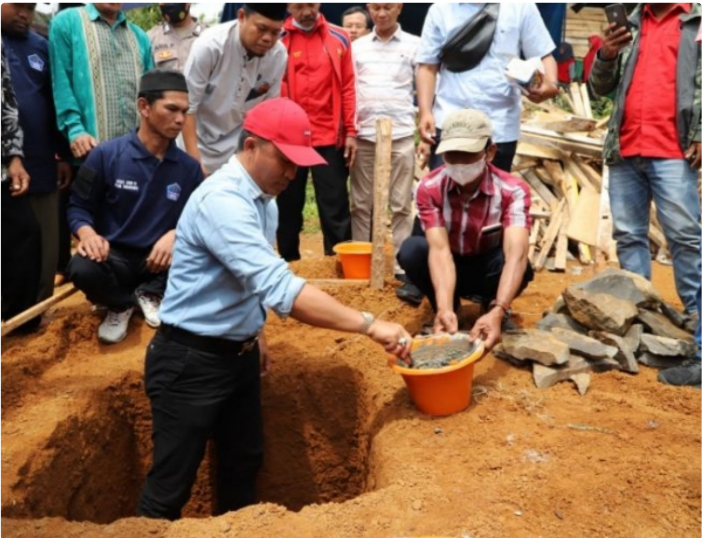
Peletakan batu pertama masjid at taqwa
